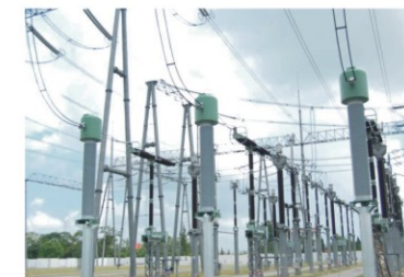
Transformador de Corriente LVQB-550 Funcionando en Filipinas LVQB-550 SF6 Current Transformer Exported to Philippine NTC
