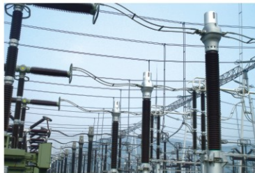
Transformadores de corriente LVB-550 funcionando en la provincia de Zhejiang LVQB-550 Oil Immersed CT in Zhejiang Province
