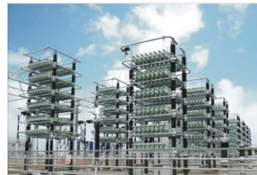
Condensador Shunt TBB525-301824/524AQW instalado para red de hipertensión \pm 800\text{kV} en la provincia de Guangdong TBB525-301824/524AQW Shun Capacitor Installation for \pm 800\text{kV} Ultra-high Voltage Converter Substation in Guangdong Province
